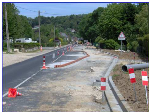
Travaux de Voirie 1 783 000 €
